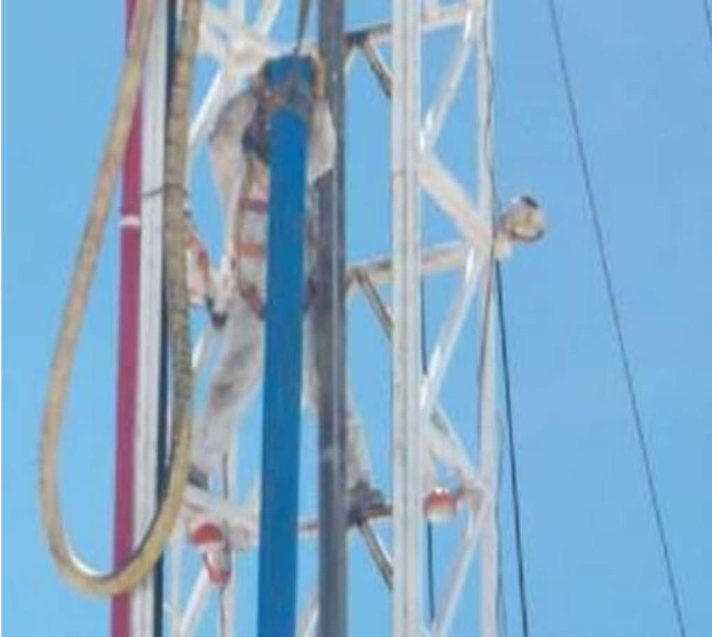
Figura 6 Entubamiento de una perforación
