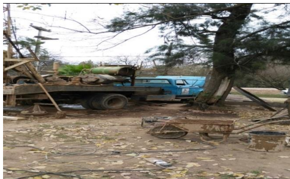
Figura 3: Fotografía de obra de perforación en ejecución
