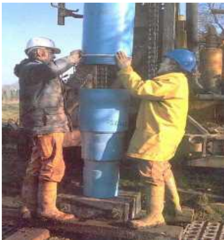
Figura 4. Entubamiento de la perforación
