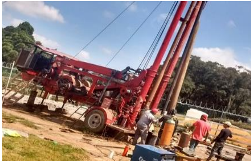
Figura 2. Fotografía de obra de perforación en ejecución
