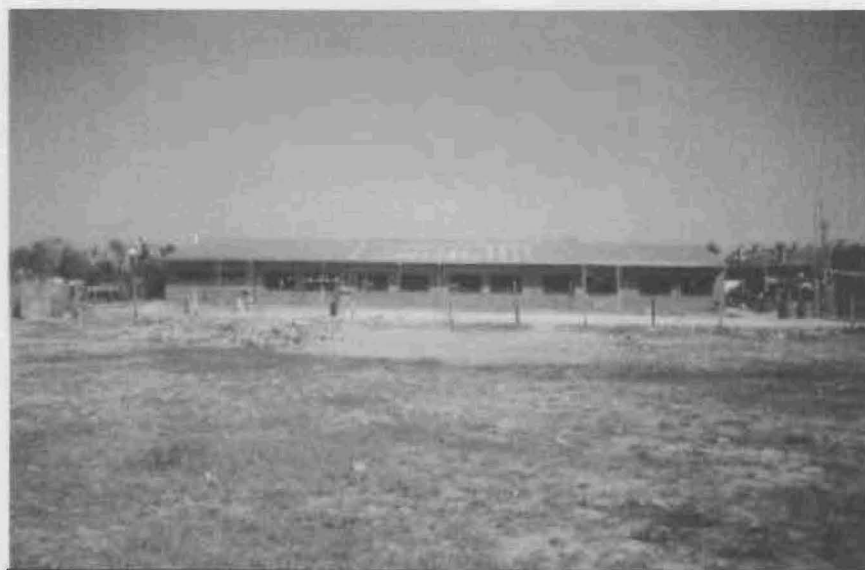
Escuela Fe y Alegría. Centro Ongay. Corrientes. Año 1998. Etapa de construcción
