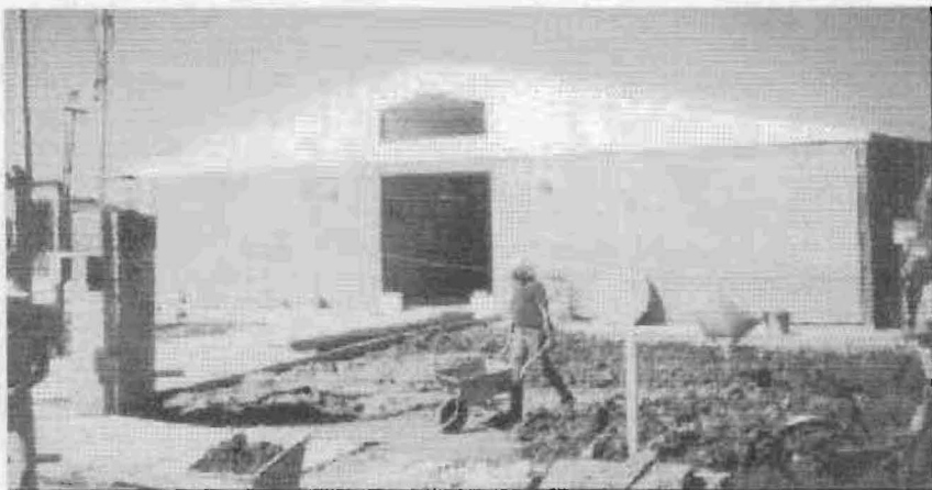
Construcción del edificio escolar Centro Ongay. Año 1998
